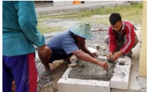
Gambar 4. Pembuatan pondasi tiang portal.
